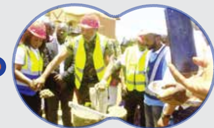
Photo 3 : Lancement travaux de construction salle des jeunes de Mahagi
